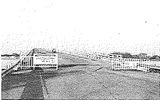
Imágenes 1 y 2. Detalle de afectación de la obra por inestabilidad del lleno en la zona de aproximación al puente.
