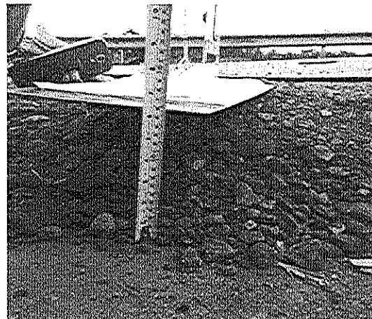
Imágenes 3 y 4. Detalle desestabilización de bolsacreto y solución provisional de tránsito peatonal y vehicular (Material orgánico y placa metálica).
