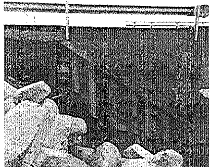
Imágenes 1 y 2. Detalle de afectación de la obra por inestabilidad del lleno en la zona de aproximación al puente.
